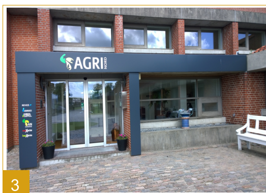
3 Alubakke produceret til indgangsparti, antrasitgrå alu.
